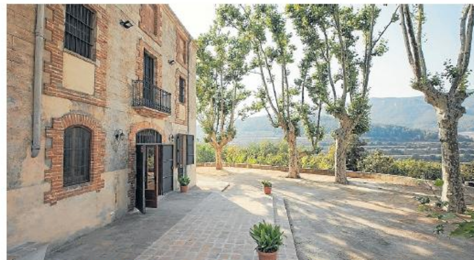
La masía construida a finales del siglo XIX empezó a funcionar como alojamiento en octubre de 2018. FOTO: CEDIDA
